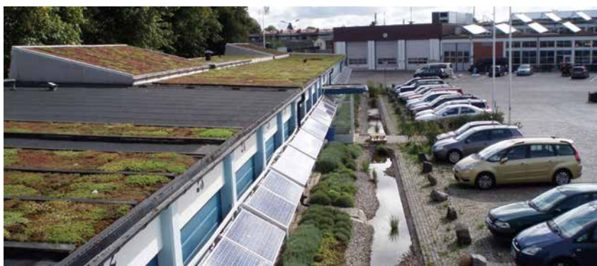
Lokal afledning af regnvand i Augustenborg, Malmö
