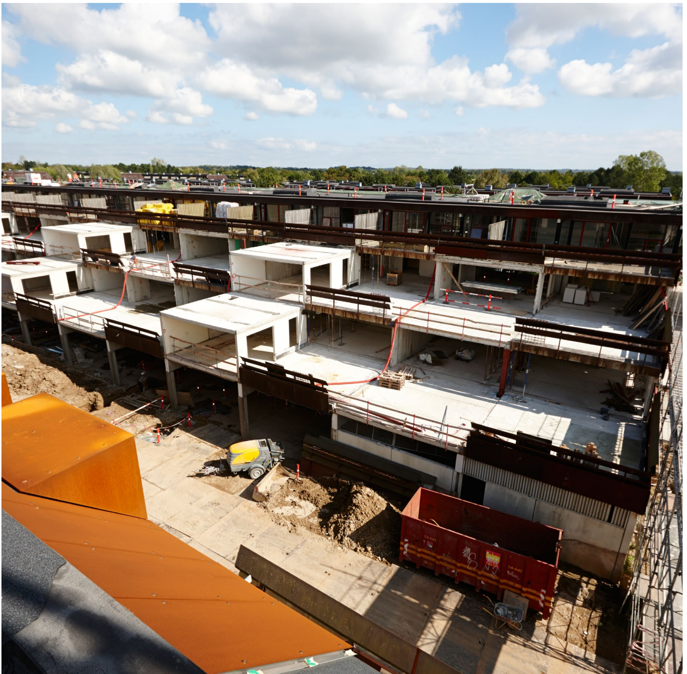
Farum Midtpunkt under ombygning, Furesø Boligselskab Foto: Byggeriets Billedbank
