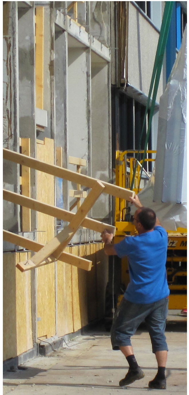
Renovering i Langkærparken, AL2bolig Fotograf: Pernille Poulsen
