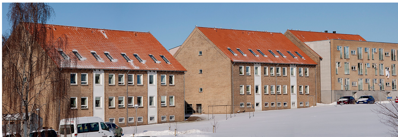
HAB afd. 15, Thrigesvej. Med en ny facadetilbygning er der opnået lyse og rummelige lejligheder på boligblok fra 1954. Se www.inspirationskatalog.dk
