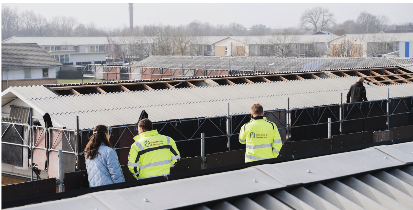
Helhedsrenovering af Granhegnet for Syd-Bo udført af byggepartnerskabet &os. Foto: Byggepartnerskabet &os.
