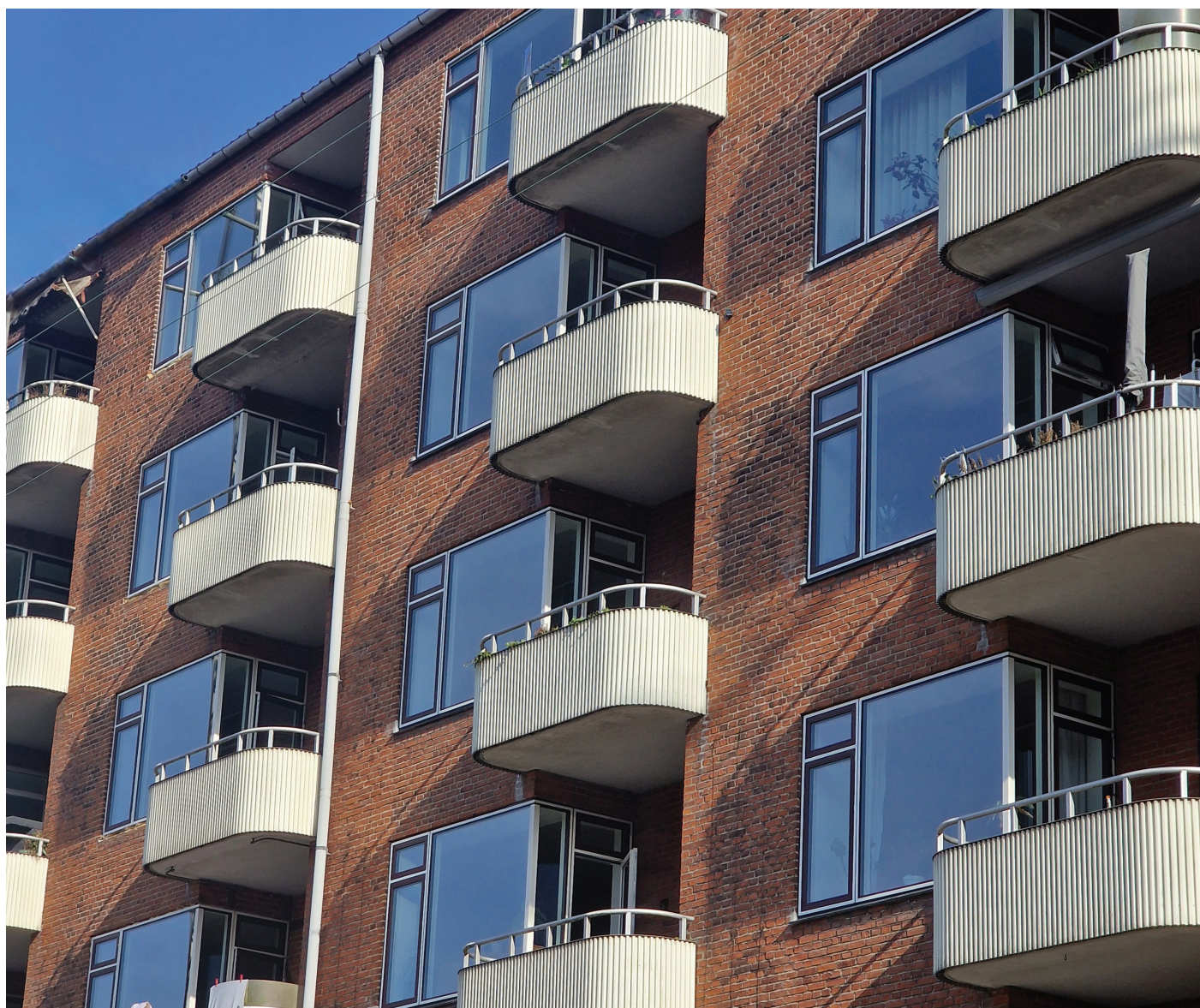
Møllelængen efter renovering udført af fsbHJEM. Foto: Nordic Office of Architecture
