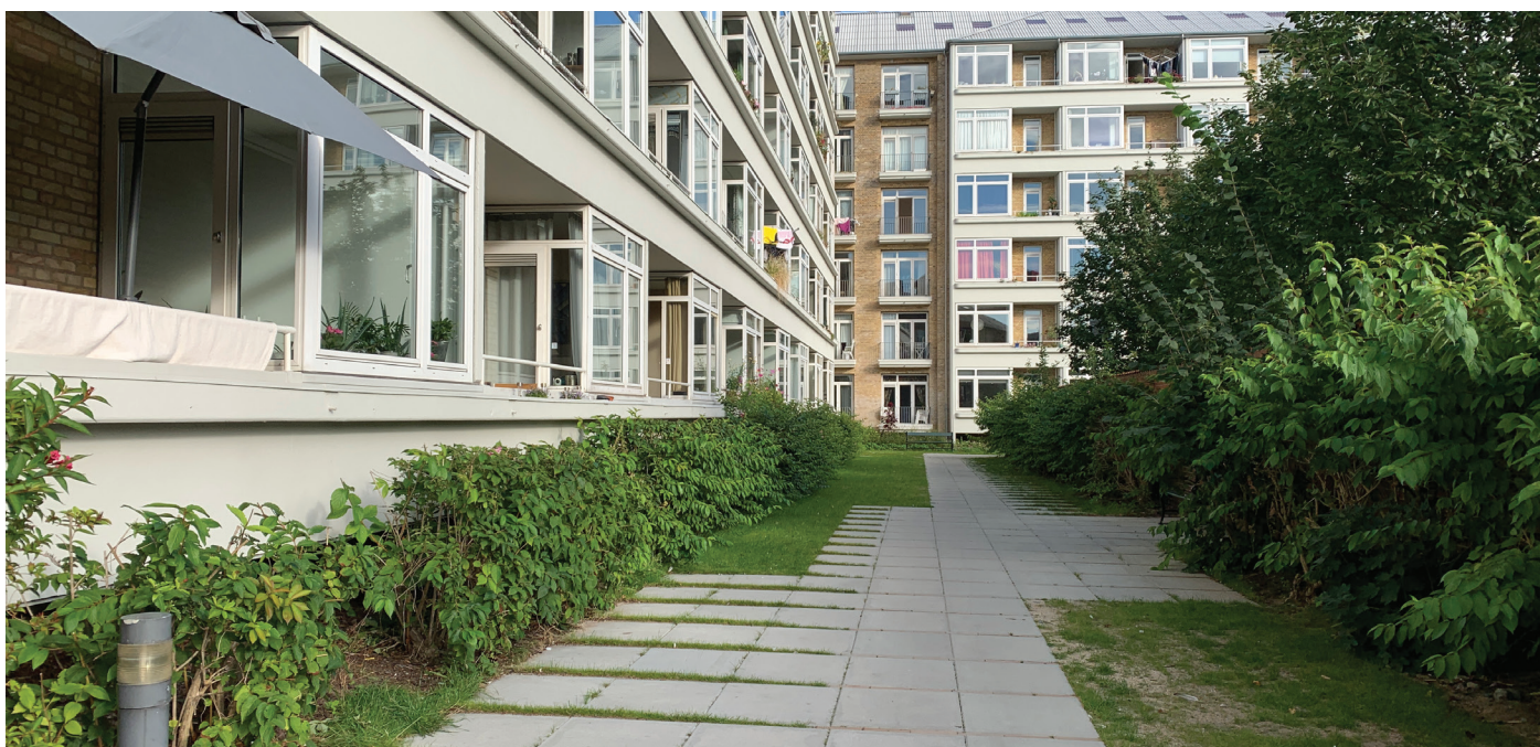
Gårdrenovering af Haunstrupgaard fra fsbHJEM. Foto: Nordic Office of Architecture.
