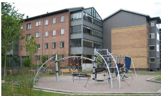
Gavlaltaner og vinduer giver godt overblik over udearealerne og dermed en naturlig overvågning af området. Foto: Marianne Alsing
