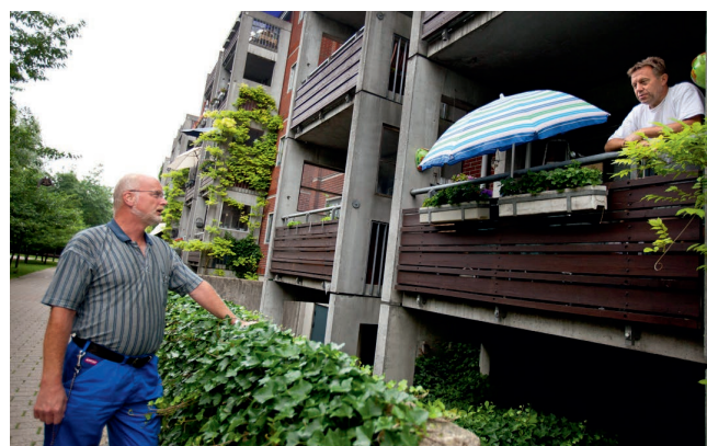
Altanen danner ramme for en snak mellem beboer og vicevært. En snak de måske ikke ville have fået hvis beboeren skulle helt ned på ejendomskontoret. Ligeledes kan altaner danne ramme for dialog mellem beboerne. Foto: Nicolas Egedorf
