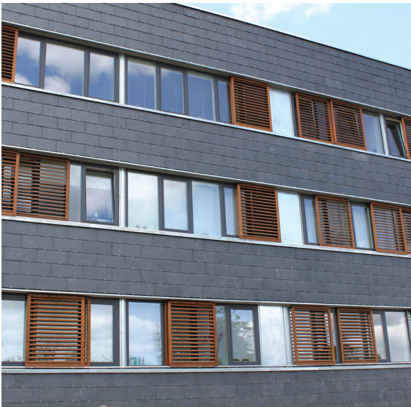
AL2bolig, Langkærparken i Tilst. Klimaskærm med præfabrikerede facadekassetter, der beklædes med naturskifer. Læs mere på www.inspirationskatalog.dk . Foto leveret af AL2bolig
