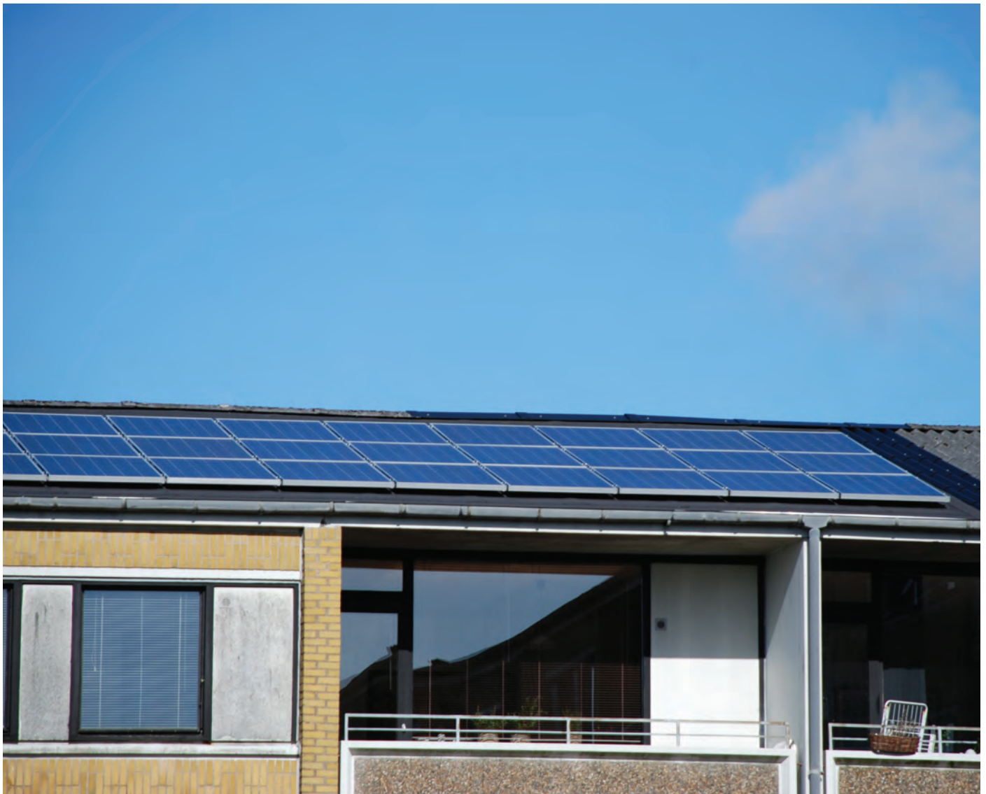
Fruehøjgaard, Brændgårdparken i Herning. Solcelleanlæg installeret på taget af tre boligblokke i 60'ers bebyggelse. Læs mere på www.inspirationskatalog.dk . Foto leveret af EnergiMidt.
