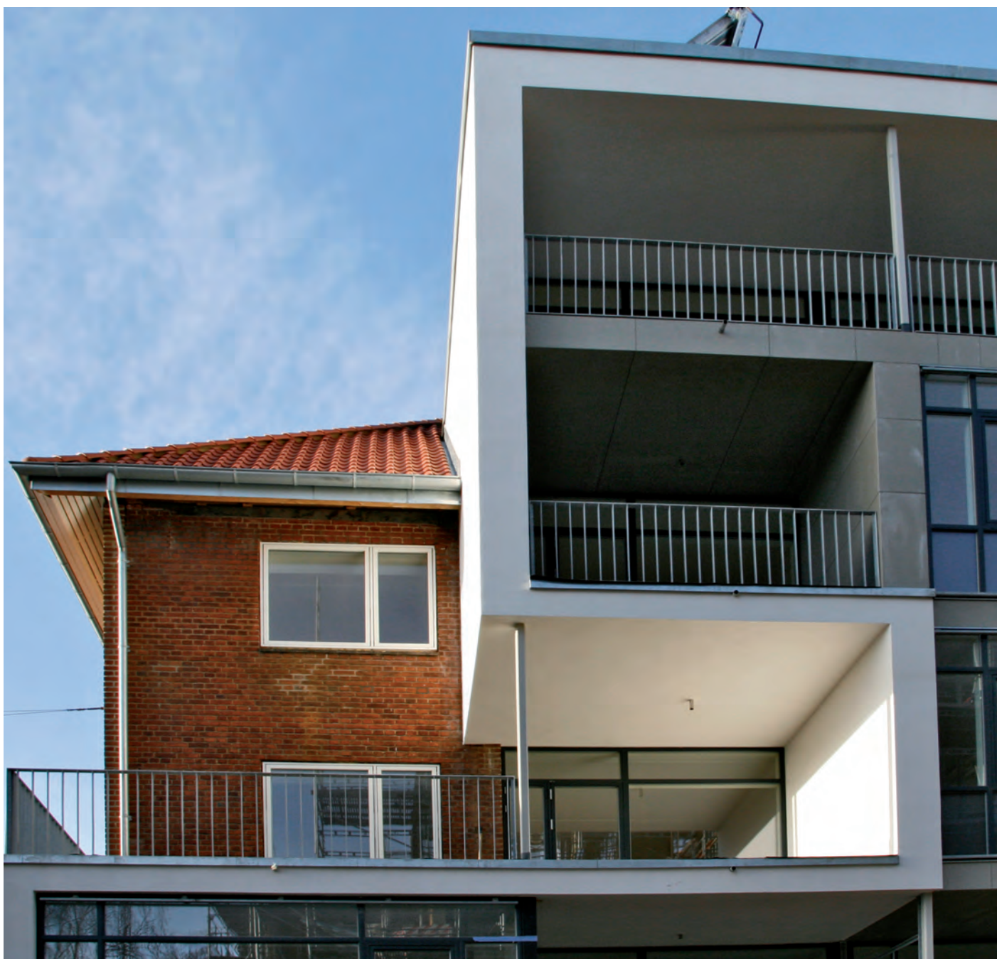
Boligforeningen Ringgården i Aarhus. Lejligheder fra 1940'erne omdannet til moderne boliger med bl.a. bedre ventilation og mindre gadestøj. Læs mere på www.inspirationskatalog.dk . Foto leveret af Boligforeningen Ringgården.
