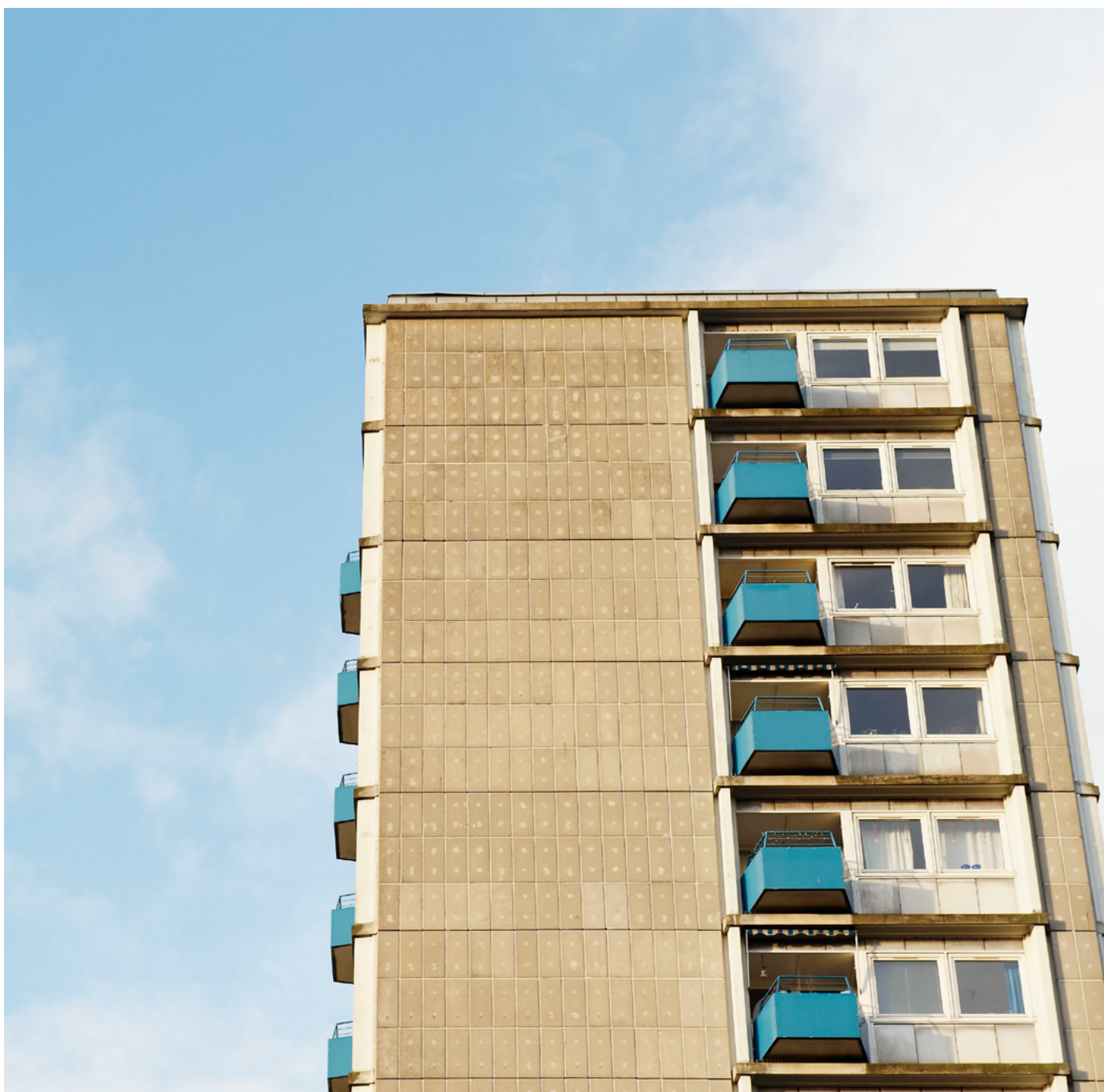
Sorgenfrivang II fra før renoveringen blev påbegyndt. Foto: Thomas Brolyng Steen.
