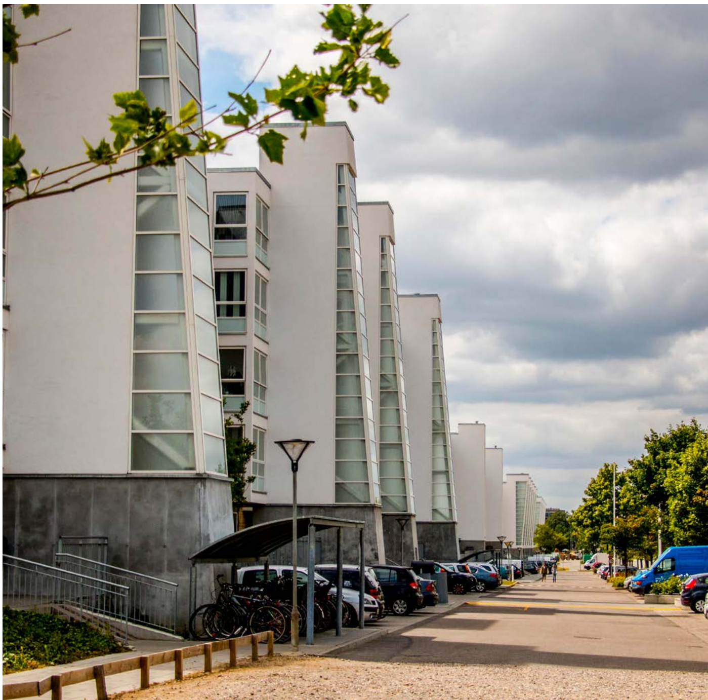
Afdeling 37, Korslækkeparken efter renoveringen. Foto: Berit Praem Jensen, FAB.
