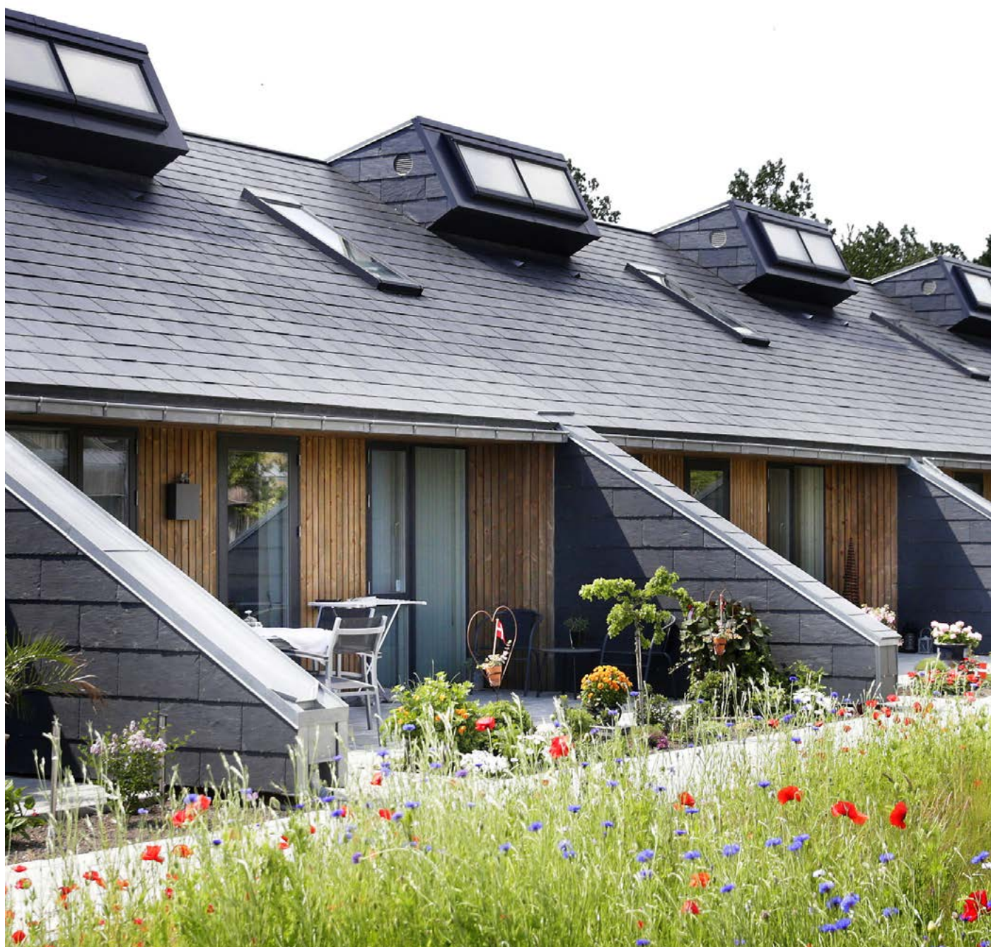
Søhusene efter renoveringen. Foto: Boligkontoret Danmark.
