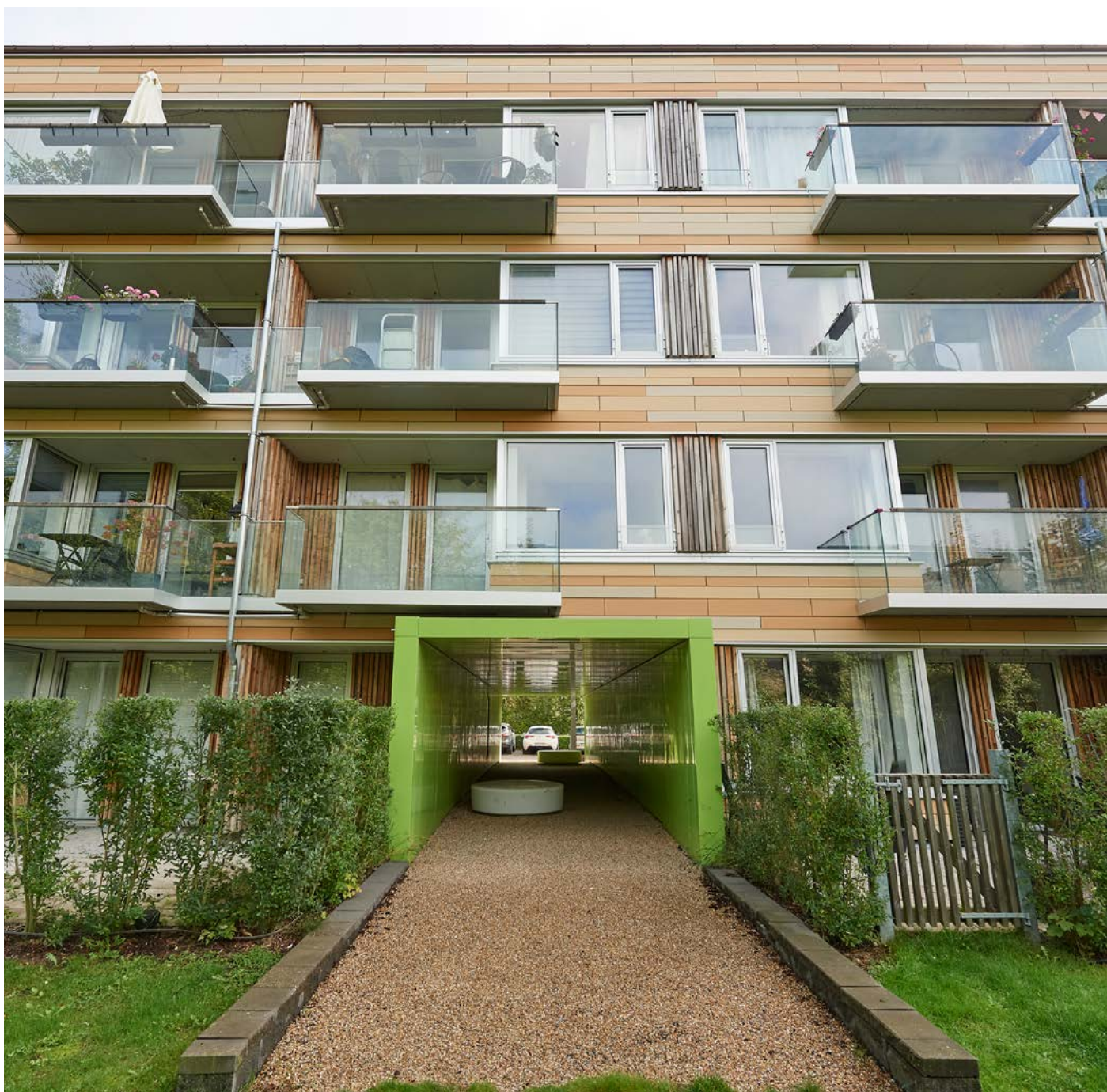
Korngården efter renovering. Foto: DAB.
