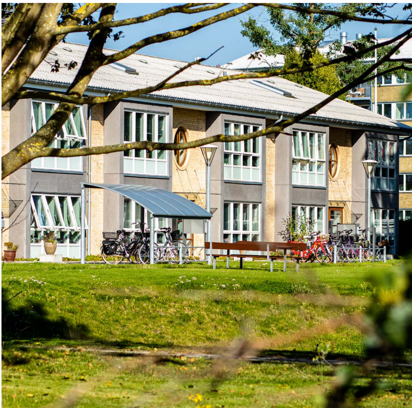
Afdeling 34, Korslækkeparken efter renoveringen. Foto: Berit Praem Jensen, FAB.
