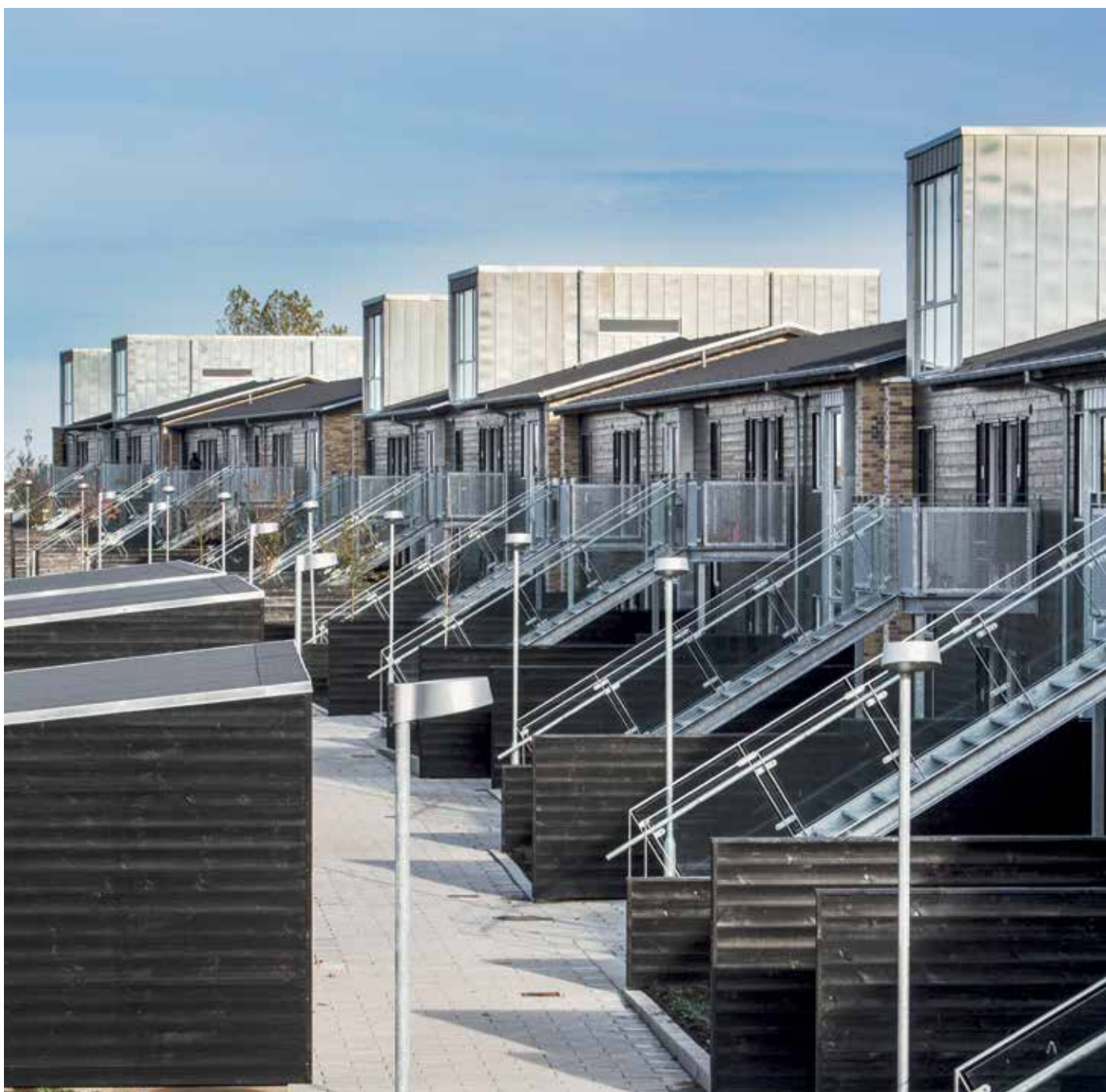
Himmerland Boligforening, Sallingsundvej i Aalborg Øst. Renovering af afdelingen er afsluttet i 2014 Foto: Himmerland Boligforening
