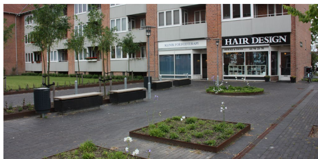
Ny belægninger og staudebede godt et år efter anlæg. Stauderne lukker stadig slet ikke tæt, så bedene ser lidt trøstesløse ud og der er græs i belægningsfladerne. Den nye plads ser allerede lidt slidt og sjuksket ud. (Vestergården 1, 3B)
