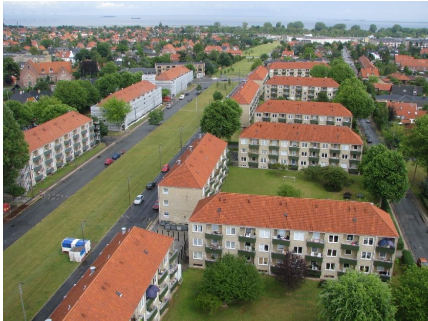
Figur 1: Luftfoto af de forskellige boligblokke, som udgør Frydenspark.
