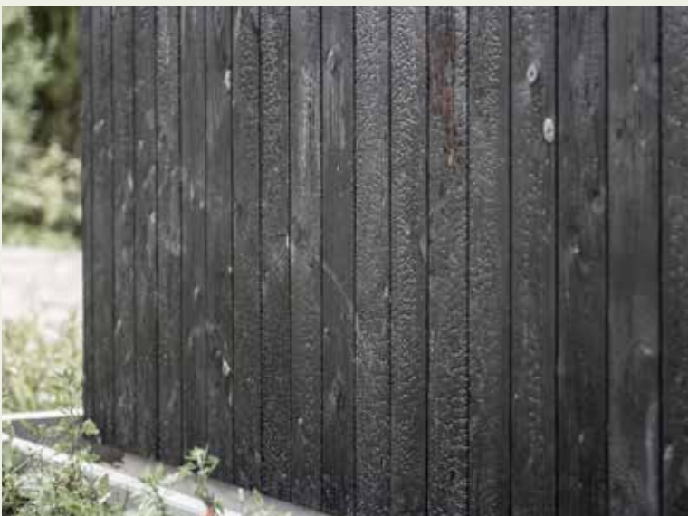
Overfladebrændt (forkullet) genbrugstræ fra eks. firmaet BurntWood's Re-Wood-setup. Træ leveret nedbrudt til Re-Wood koster kr. 400,- pr. ton. Renset og skåret i længder koster kr. -300,- (salgspris til Re-Wood)
