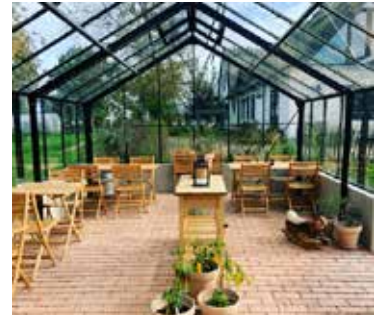
Orangeri - genbrug af vinduer og mursten
