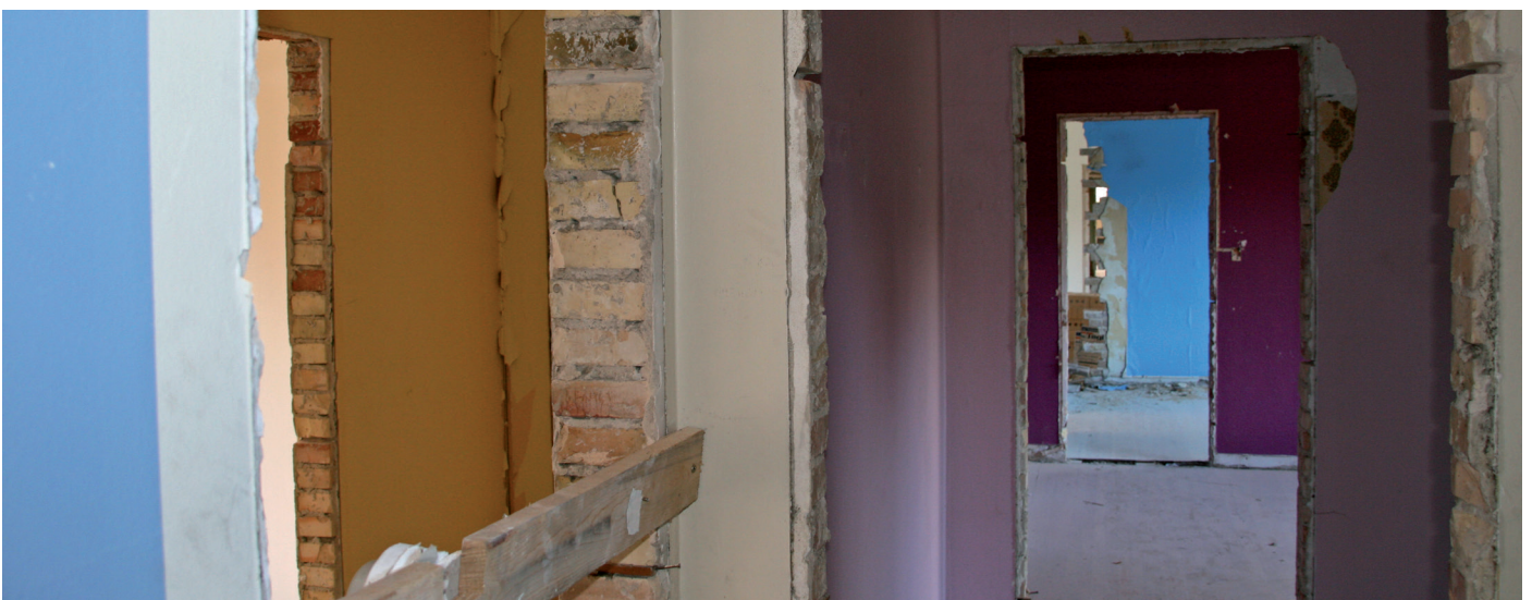
Renovering af boligforeningen Ringgården, afdeling 1 i Aarhus.
