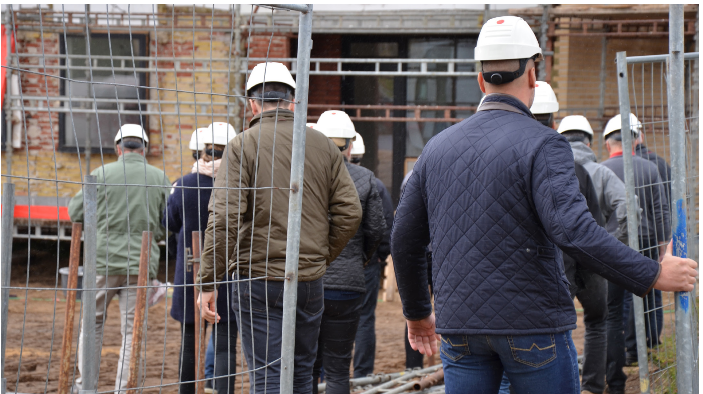
Byggeplads. Rødkærparken i Viborg. Foto: AlmenNets sekretariat.
