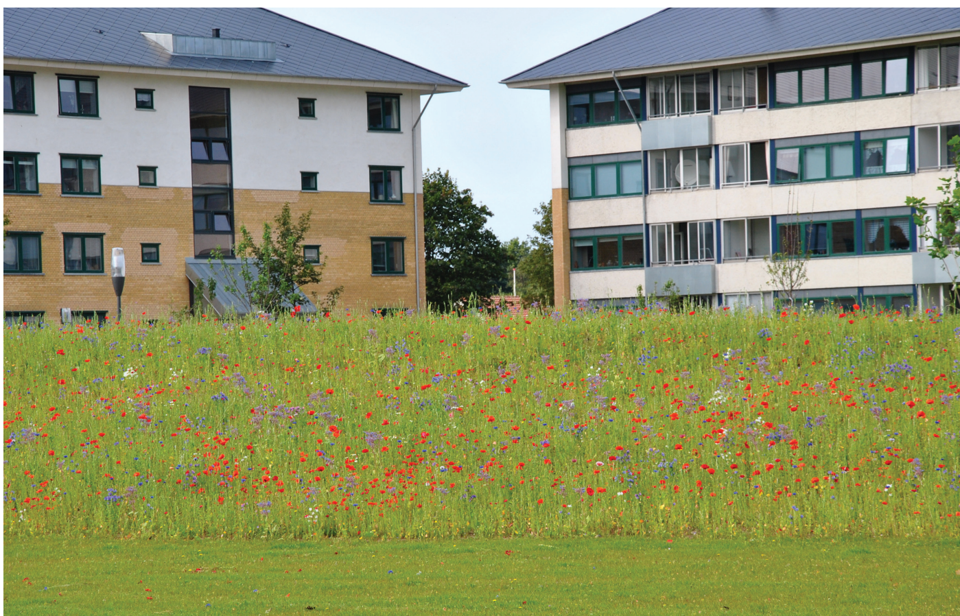
Renovering af Hånbæk (Frederikshavns boligforening) med stor beboerinddragelse. Læs mere på www.inspirationskatalog.dk . Foto leveret af Finn Lefevre Olsen og Arkinord A/S
