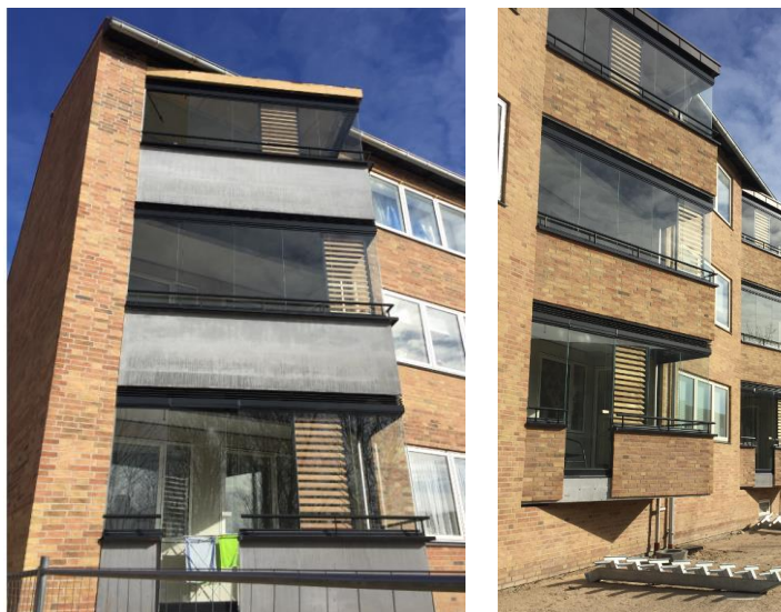
Figur 12 – Referencebilleder fra HiCon (Skolegade). Til venstre er altanerne sat op rå, til højre er murskaller påmuret
