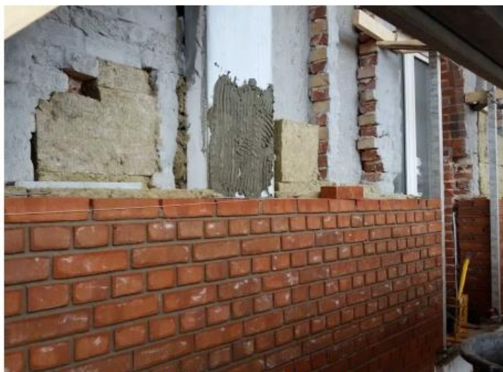
Foto 22: Opmuring i gang ud for EPS-søjle i hulmuren. Bemærk der mures vådt i vådt med lim på EPS-søjlen.
