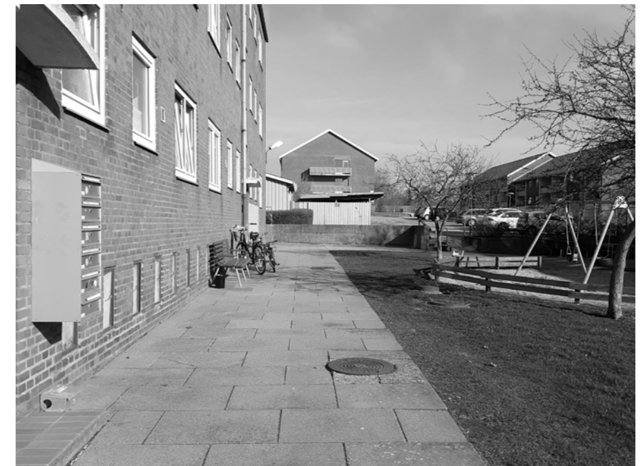
F: Vaske- & cykelrum samt kantzone - Nørre Allé 53-55 - Blok 10
