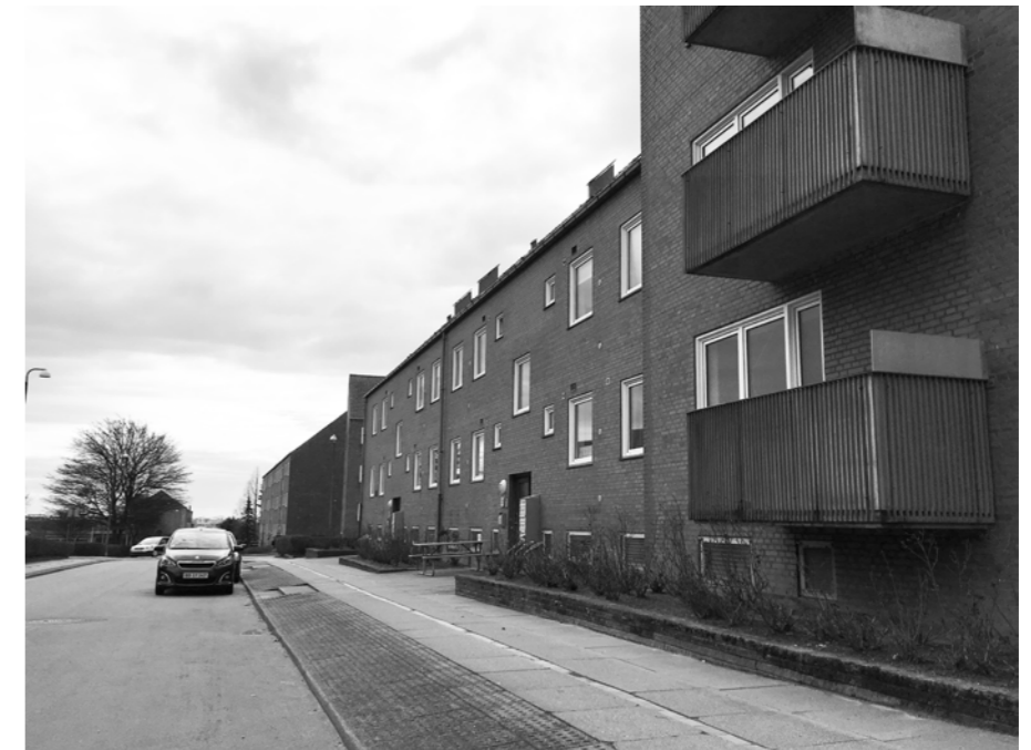
C: Kantzone - Nyvangsvej 15-17 - Blok 17
