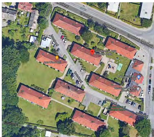
Fig. 1. Lystoftehuse, kilde: Google
